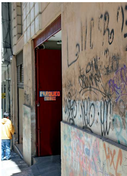
Deterioro de la propiedad privada.
