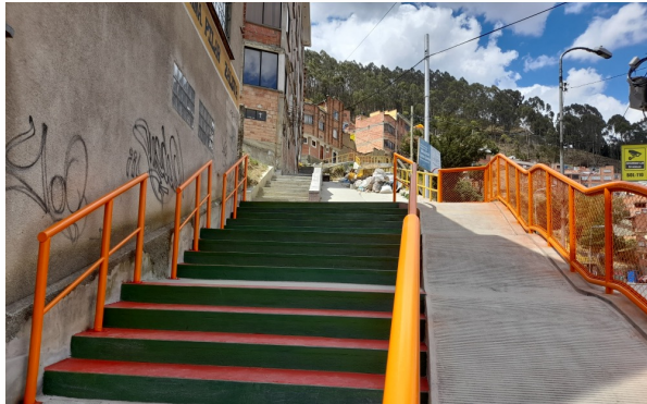
RECONSTRUCCIÓN GRADERÍAS Y OBRAS COMPLEMENTARIAS - PERIFÉRICA
