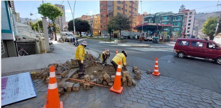
RECONFORMACIÓN DE ADOQUINADO
