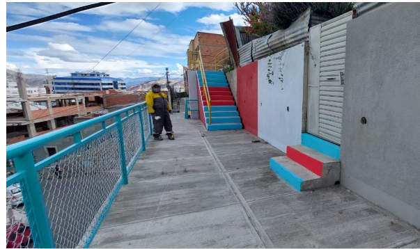
PINTURA GRADERÍAS JUAN MANUEL LOZA
