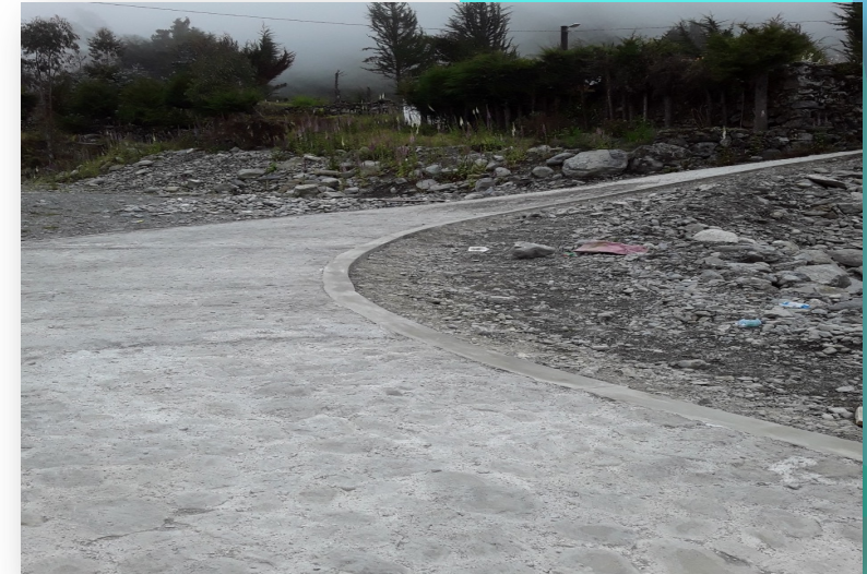
MEJ. VIAL ENTRE PROGRESIVA 0+000 A 0+030 DE ACCESO A LA COMUNIDAD CUTICUCHO
