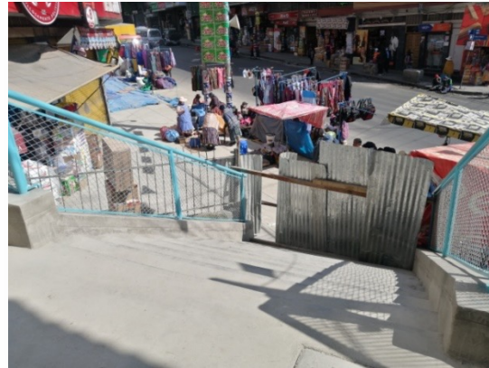
RECONST. GRADERIAS Y OBRAS COMPLEMENTARIAS FINAL CALLE ISAAC TAMAYO Y AVENIDA MANCO KAPAC ZONA EL ROSARIO
