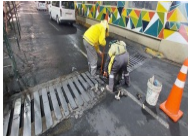
LIMPIEZA DE SUMIDEROS CALLE HONDA
