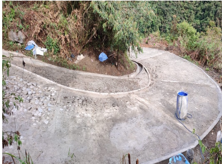
MEJ. VIAL DE PROGRESIVA 0+850 A PROGRESIVA 0+890 COMUNIDAD PUEBLO DE ZONGO
