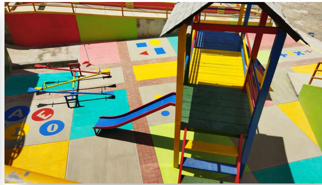
RECONSTRUCCIÓN ÁREA RECREATIVA MAX PAREDES
