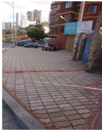
CONST. ENLOSETADO C. S/N 2 ENTRE C. PROLONG. MONTEVIDEO Y PJE. D. SAVIO ZONA UNIVERSIDAD - CANCHA ZAPATA
