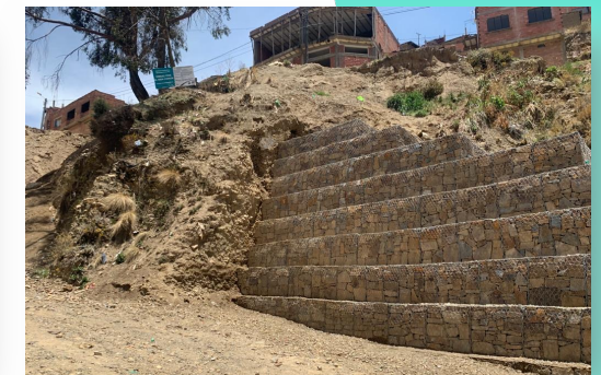
ESTABILIZACIÓN CON MURO DE GAVIONES MAX PAREDES
