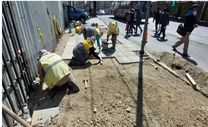
RECONSTRUCCIÓN PARCIAL DE ACERAS
