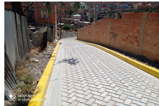
ENLOSETADO Y OBRAS COMPLEMENTARIAS SUR
