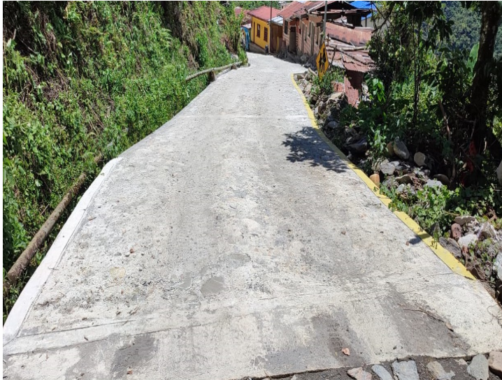
MEJ. VIAL TRAMO DESDE LA UNIDAD EDUCATIVA HACIA EL PUENTE YAHUILACA COMUNIDAD CAHUA GRANDE
