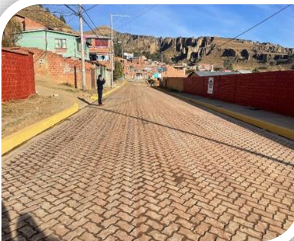
ENLOSETADO ZONA KELLUMANI CHIJPATA Monto Bs. 163.681
