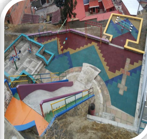
OBRAS DE MEJORAMIENTO ZONA HUANU HUANUNI Monto Bs. 219.126
