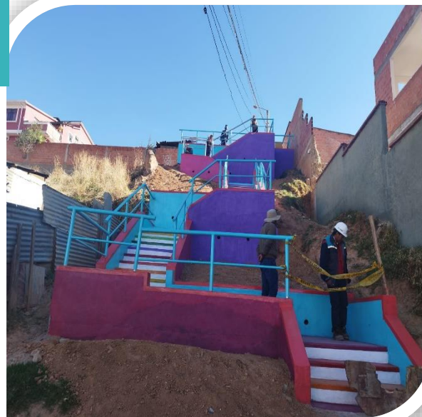
GRADERÍAS ZONA COMPLEMENTACIÓN PEDREGAL Monto Bs. 135.861
