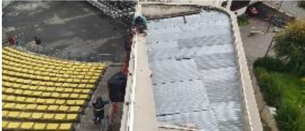
Impermeabilización de cubierta de baños.
