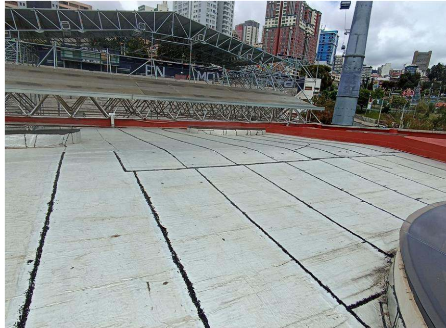
Cubierta impermeabilizada
