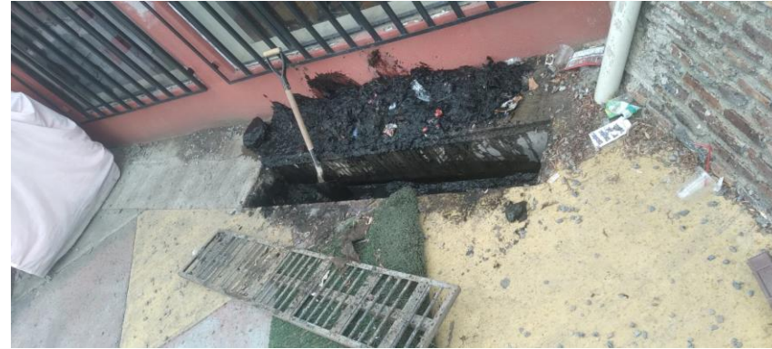
limpieza de sumidero
