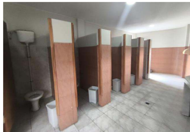
Vista general de los baños refaccionados y limpios, listos para el evento internacional
