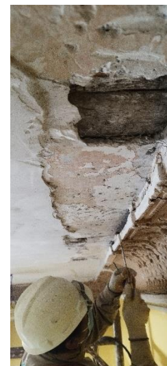
TRABAJOS DE EMERGENCIA EN LA UE ECUADOR 2024
