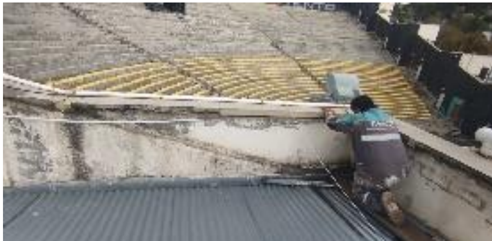
Impermeabilización de cubierta de baños.
