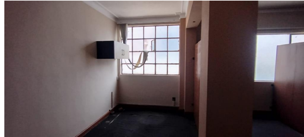
Mampara de División en Oficinas, traslado e instalación de mobiliario
