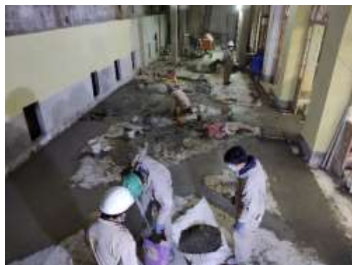
Hormigonado de Piso de hormigón simple en el ambiente PB 08
