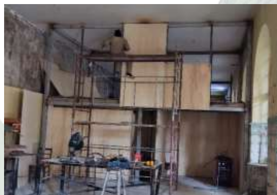
Revestimiento de mamparas con multilaminado en planta alta o mezzanine
