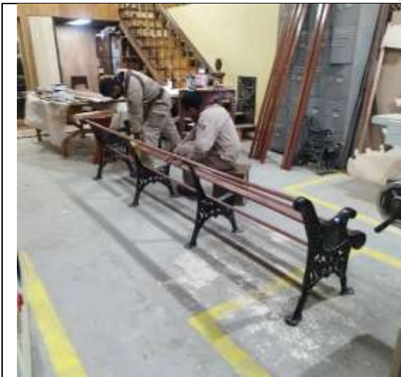
Seccionado y tratamiento de madera para la restitución de la última banca
