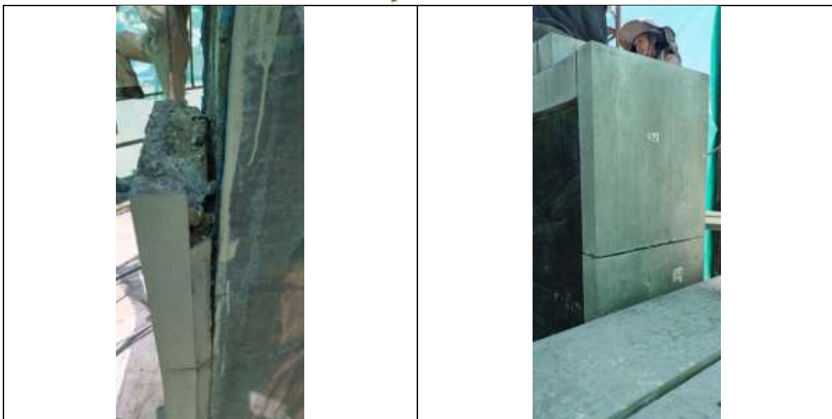
Restauración del conjunto escultórico de la plaz Eguino en proceso
