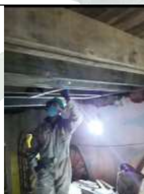
Consolidación del forjado del entrepiso mediante entramado con madera y refuerzo metálico del cielo raso nueva sede de la ETRLP Juancito Pinto (en proceso)
