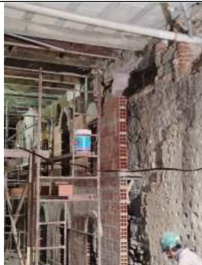
Construcción de muro cortina con arcos de medio punto y apuntado
