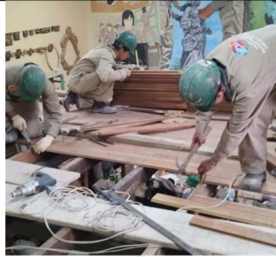
Punteado mediante combo y punta para el contrapiso de la s gradas
