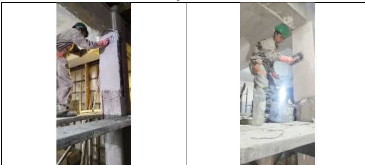
Practicas de revoque de yeso ampliación de espacios RTRLP
