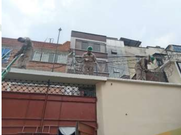
Instalación alambre de concertina tipo cuchillas en la cabecera del muro que da a la calle para valla de seguridad
