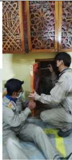
Instalación de marcos y hojas en los vanos de limpieza en el muro cortina
