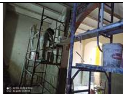
Revoque interior de yeso en la nueva sede de la ETRLP Juancito Pinto (en proceso)
