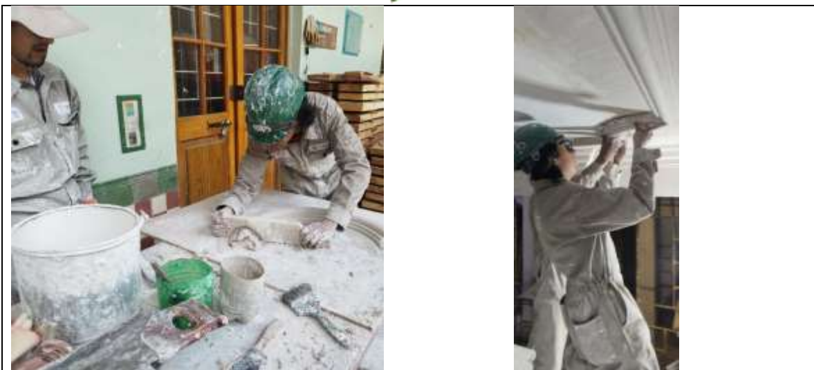
Procesos constructivos de revocos de cal y arena, de yeso y molduras corridas.
