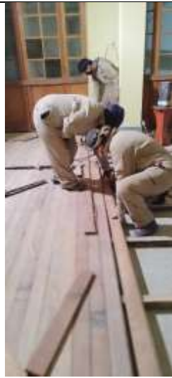
Colocado de machihombre en el piso de área de acabados carpintería
