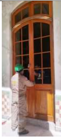
Colocado de portón de dos hojas ambiente PB 04
