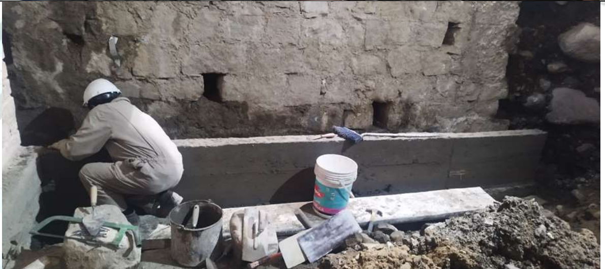
Construcción de canal recolector de aguas subterráneas
