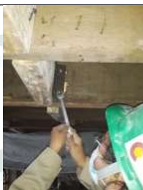
Consolidación del forjado del entrepiso mediante entramado con madera y refuerzo metálico del cielo raso nueva sede de la ETRLP Juancito Pinto (en proceso)
