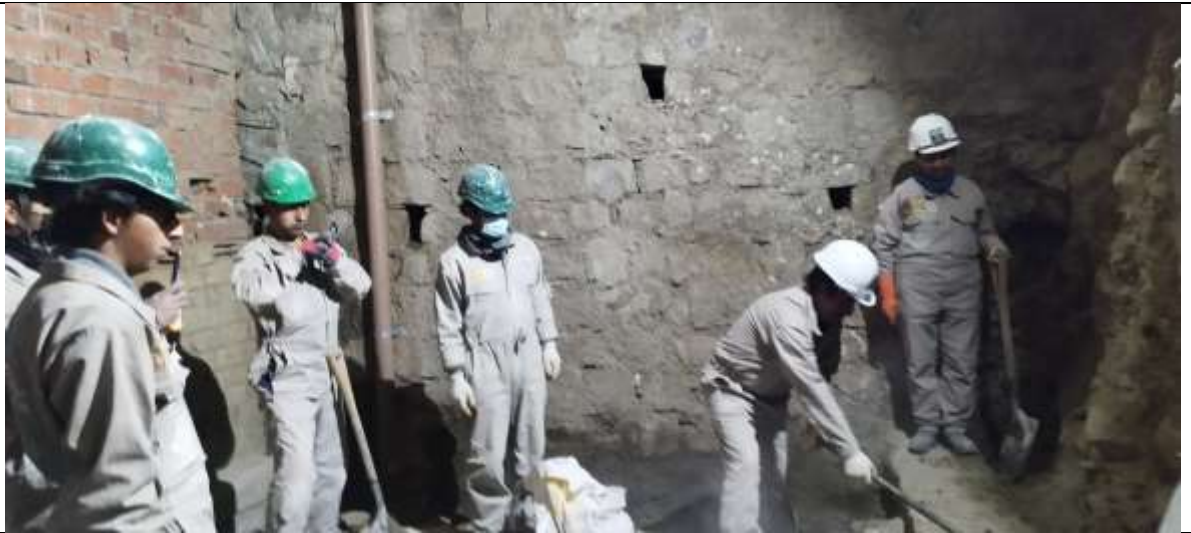
Demolición del cinto de hormigon ciclopeo
