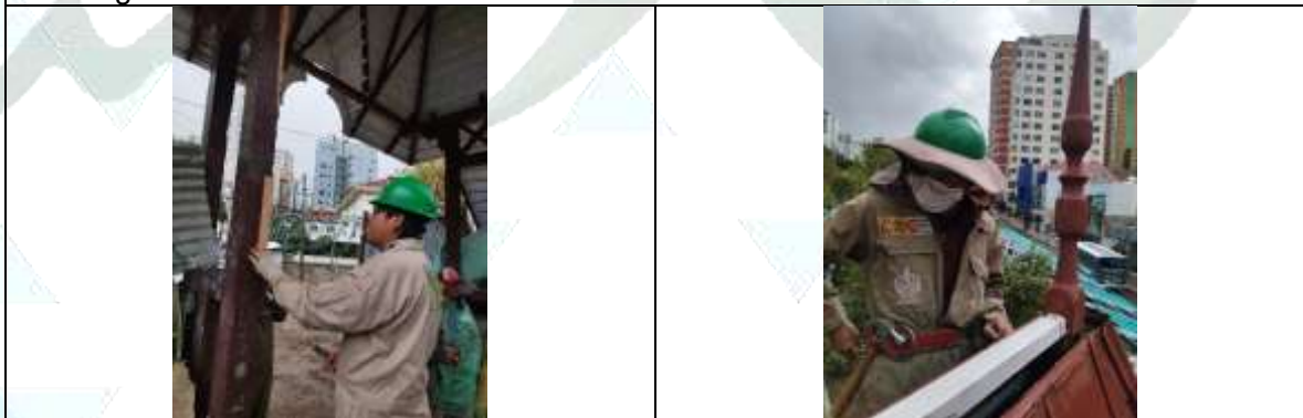
Reintegro de faltantes en los pies derechos y consolidación del maderamen de la cubierta de los Pórticos
