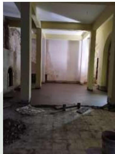
Empedrado y vaciado de contrapiso de hormigón simple
