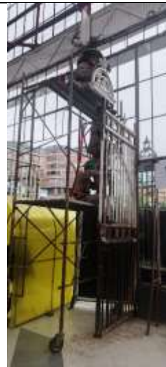
Consolidación y decapado de la capa pictórica del conjunto de la reja del ingreso principal de la Terminal de Buses La Paz
