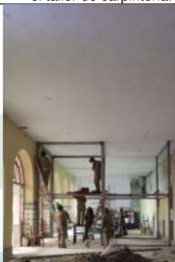
Ensamble mediante soldadura eléctrica de la estructura metálica para la mampara
