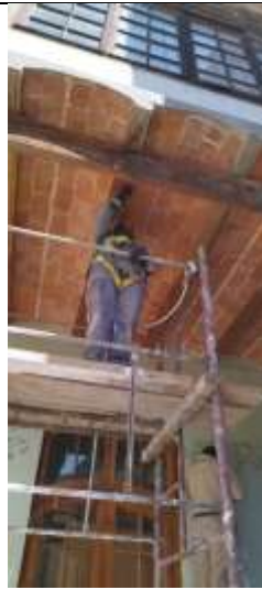
Tratamiento y rehidratación de la madera de la bovedilla
