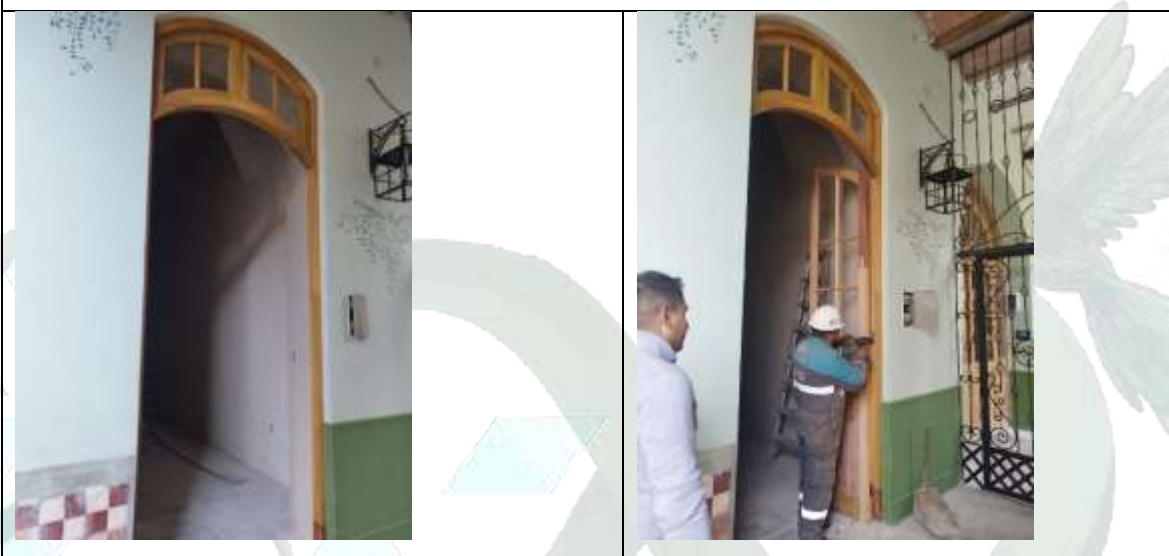
Instalado de as hojas y colocado de vidrios en el portón del ambiente PB 06 en Juancito Pinto
