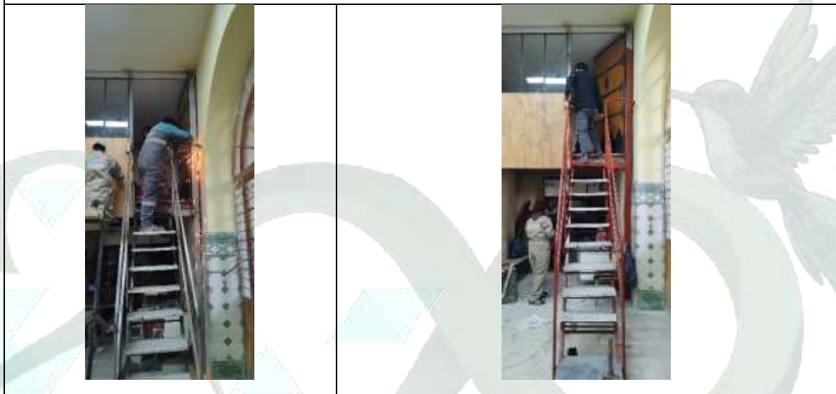
Construcción, instalación y aplicación de pintura anticorrosiva, baranda metálico en gradas de la oficina del monitor de Forja
