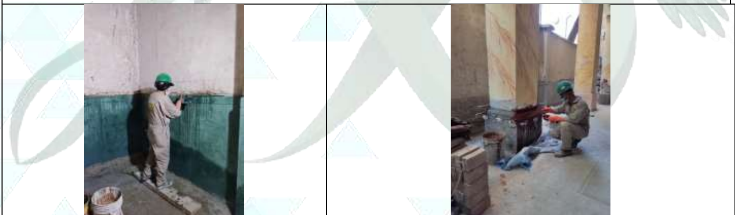
Revoque de zócalo con acabado de enlucido de color
