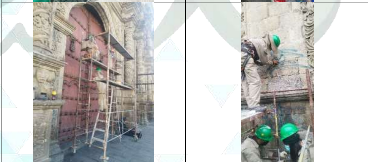
Eliminación de grafitis en la fachada principal de la Basilica menor de San Francisco
