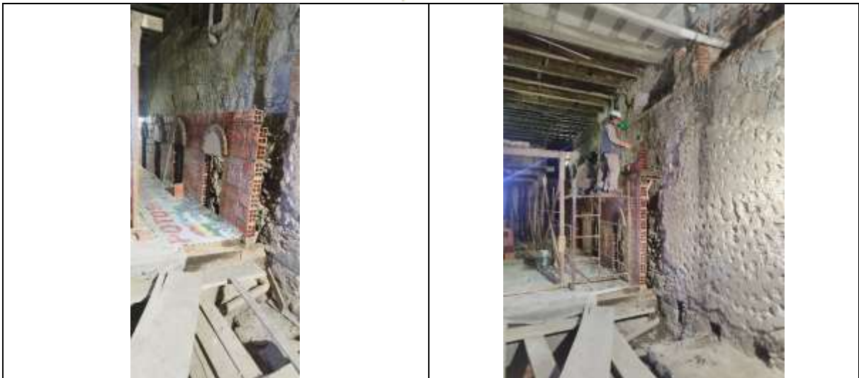
Construcción de muro de ladrillos de 6 H
