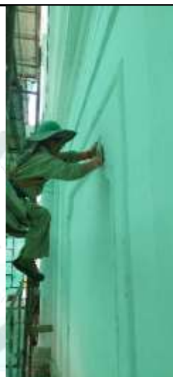
Masillado, pulido, pintura exterior látex y aplica capa protectora
