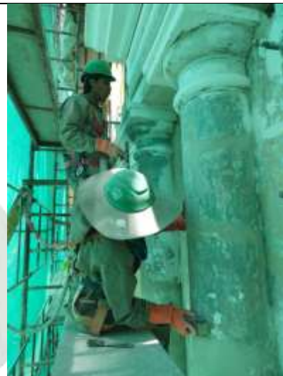
Reintegro de faltantes en los procesos constructivos de la fachada principal de la Terminal de Buses
