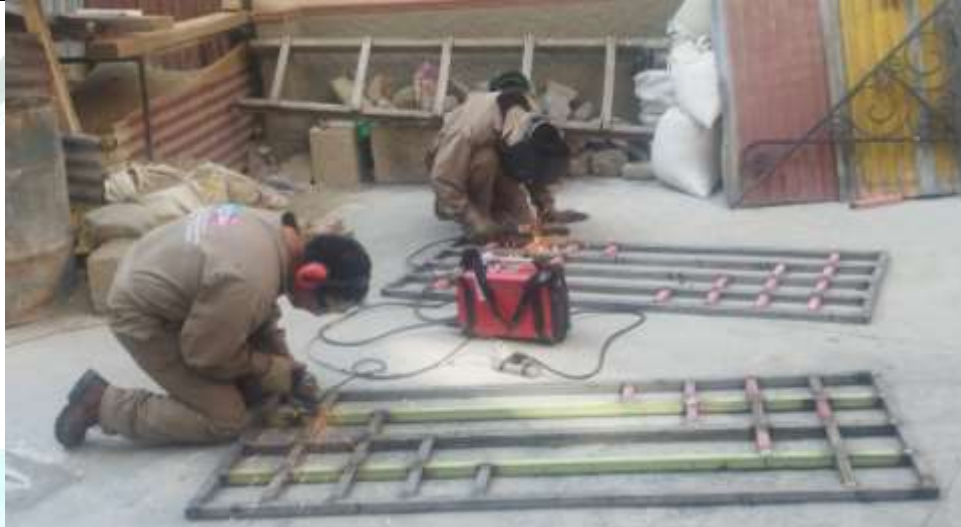
Unión de costaneras mediante soldadura de arco para el altillo de taller de talla
