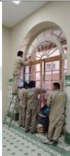
Decapado de la capa pictórica en portones en ambiente PB 07
