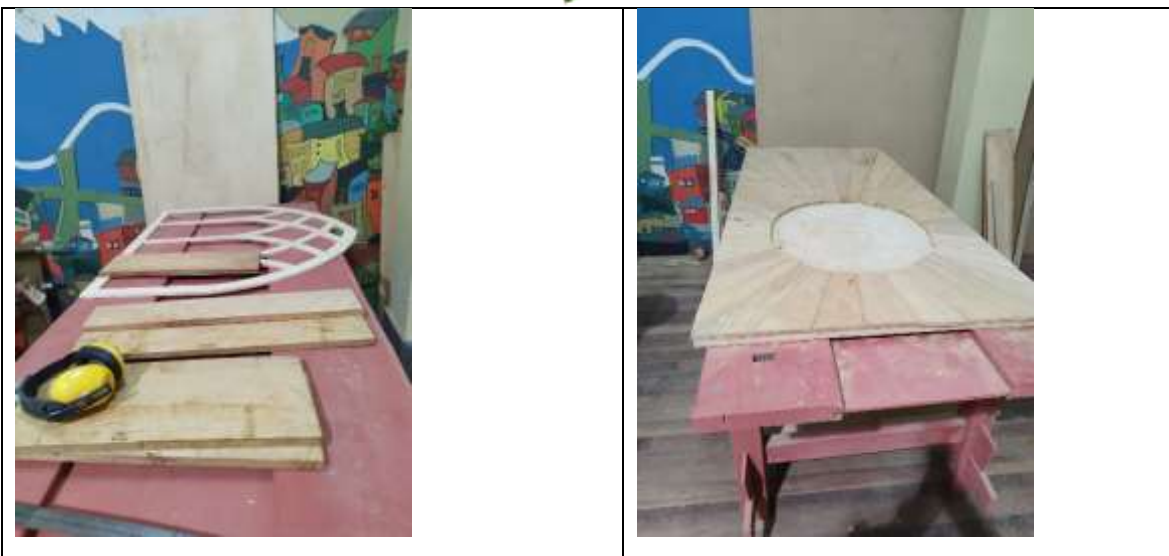
Elaboración de ventana y puerta para la oficina del monitor
