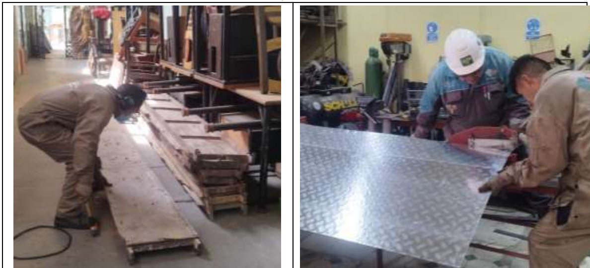
Sustitución de multilaminado por plancha de aluminio antideslizante en la plataforma de los andamios
