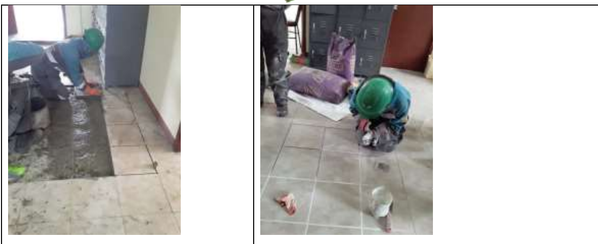
Trabajos de mantenimiento en casa distrital Warmi Qamasa
