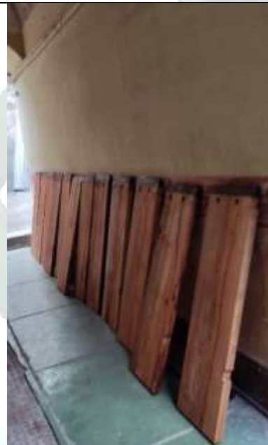
Tratamiento madera para huellas y contrahuellas de la escalera
