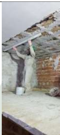
Tratamiento y rehidratación de la madera de la bovedilla
