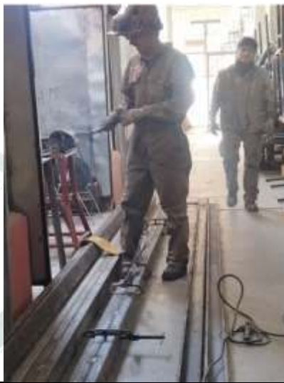
Unión de costaneras mediante soldadura de arco para el altillo de taller de talla
