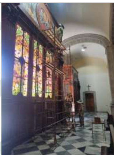
Armado de andamio para la restauración de vitrales y puertas laterales de la Catedral Metropolitana
