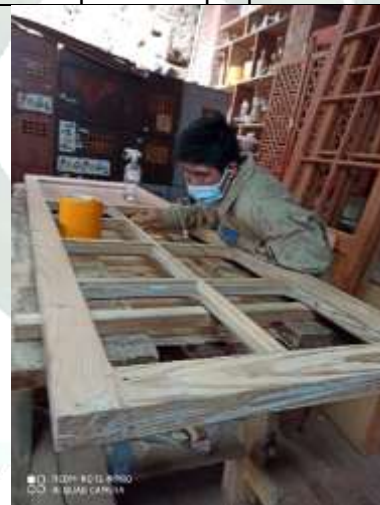
Restauración de puertas de madera de pino Oregón en proceso
