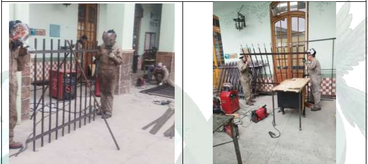
Construcción de rejas para el Atrio de la Basílica Menor de San Francisco
