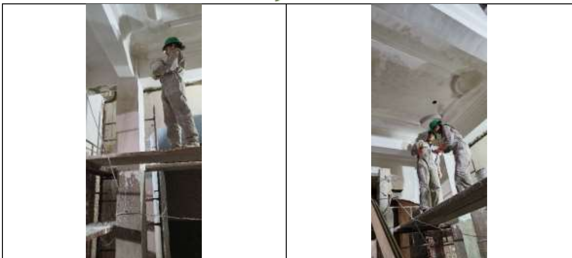
Elaboración de molduras corridas de yeso (complemento de esquineras de recuadros)
