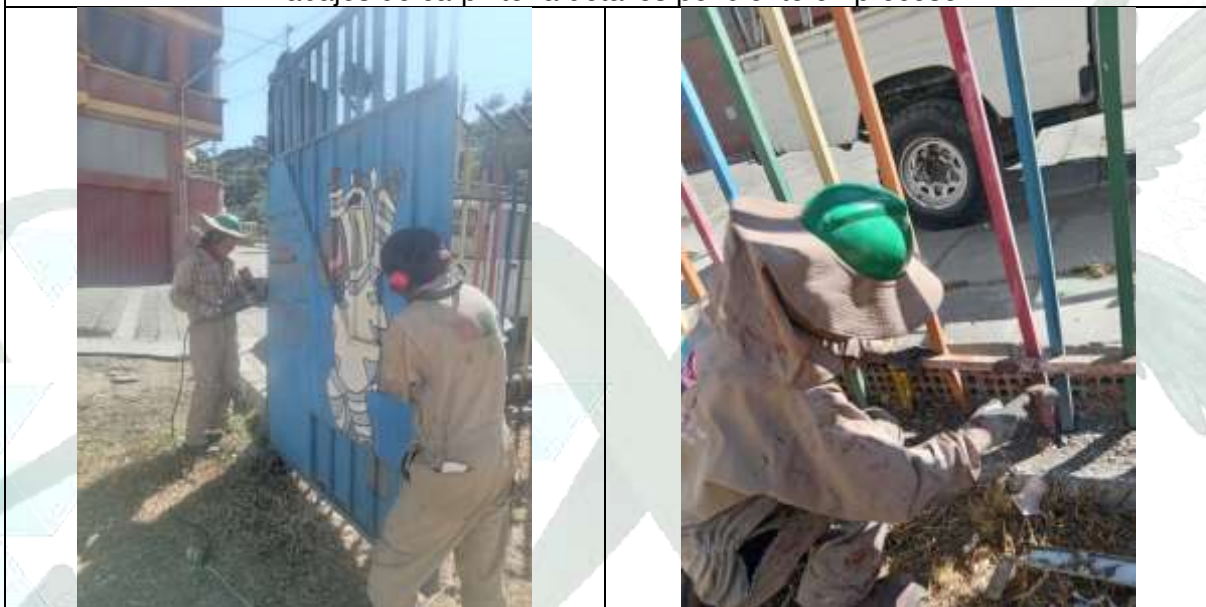
Consolidación estructural de las rejas de seguridad de la Casa de Cebras
