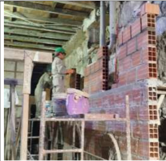
Construcción de muro cortina con arcos de medio punto y apuntado
