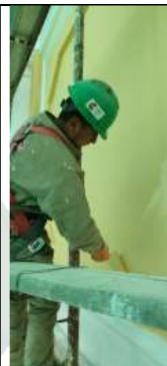
Masillado, pulido, pintura exterior látex y aplica capa protectora
