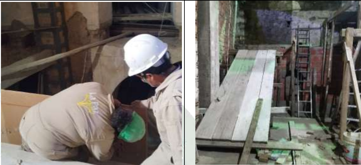
Trazado y encofrado para ala esclera de hormigon armado
