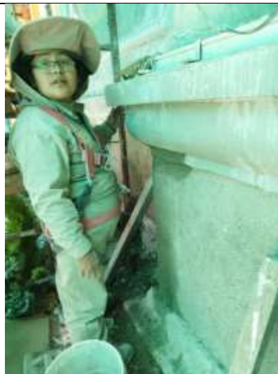
Reintegro de faltantes en elememntos ornamentales Fachada principal Terminal de buses
