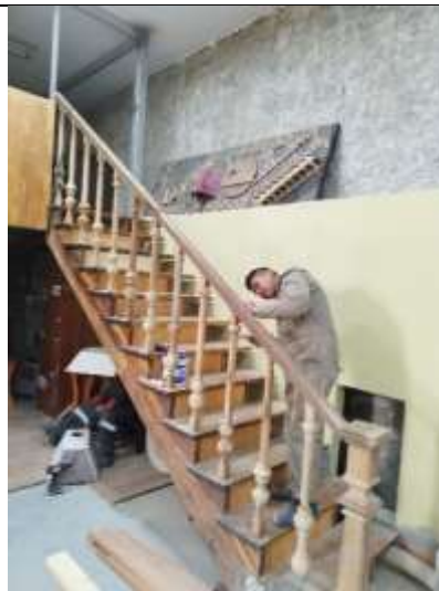
ensamblado de barrotes y pasamanos del barandado de las gradas de madera
