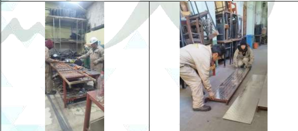
Sustitución del multilaminado por aluminio antideslizante de aluminio
