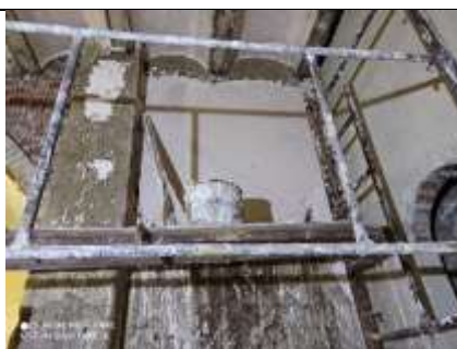
Revoque interior de yeso en la nueva sede de la ETRLP Juancito Pinto (en proceso)
