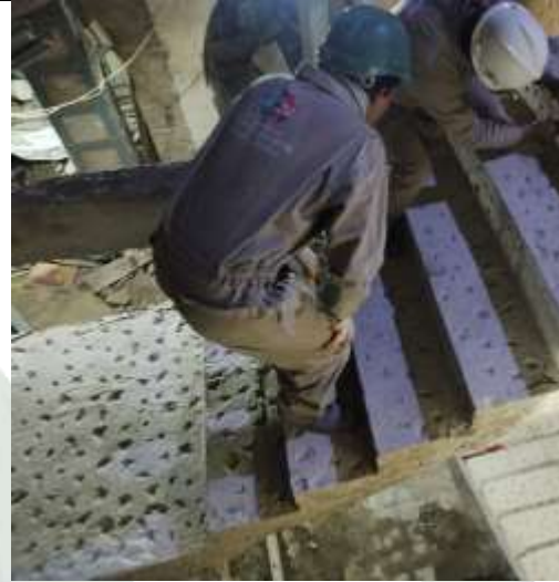
Punteado mediante combo y punta para el contrapiso de la s gradas
