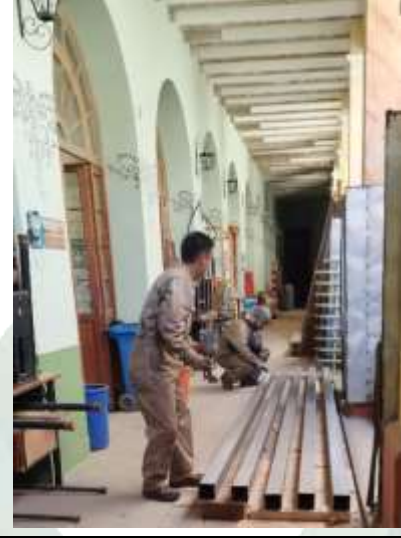
Unión de costaneras mediante soldadura de arco para el altillo de taller de talla
