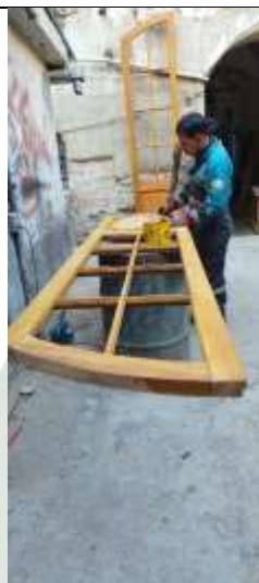
Etapas de acabado del portón de dos hojas del ambiente PB 06
