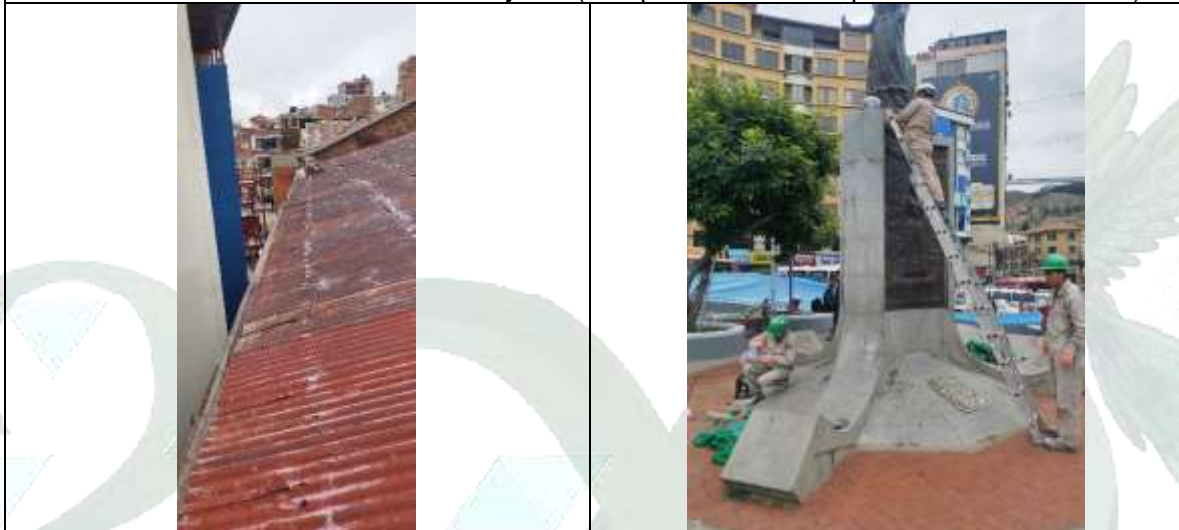
Limpieza de canaletas en la cubierta de la sede de la ETRLP
