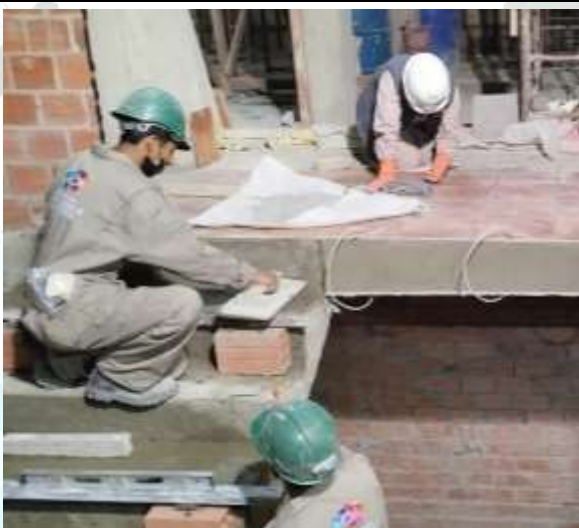
Desencofrado en gradas
