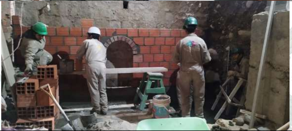
Construcción de muro cortina con vano de arco de \frac{1}{2} punto
