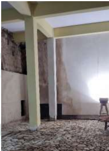
Empedrado y vaciado de contrapiso de hormigón simple
