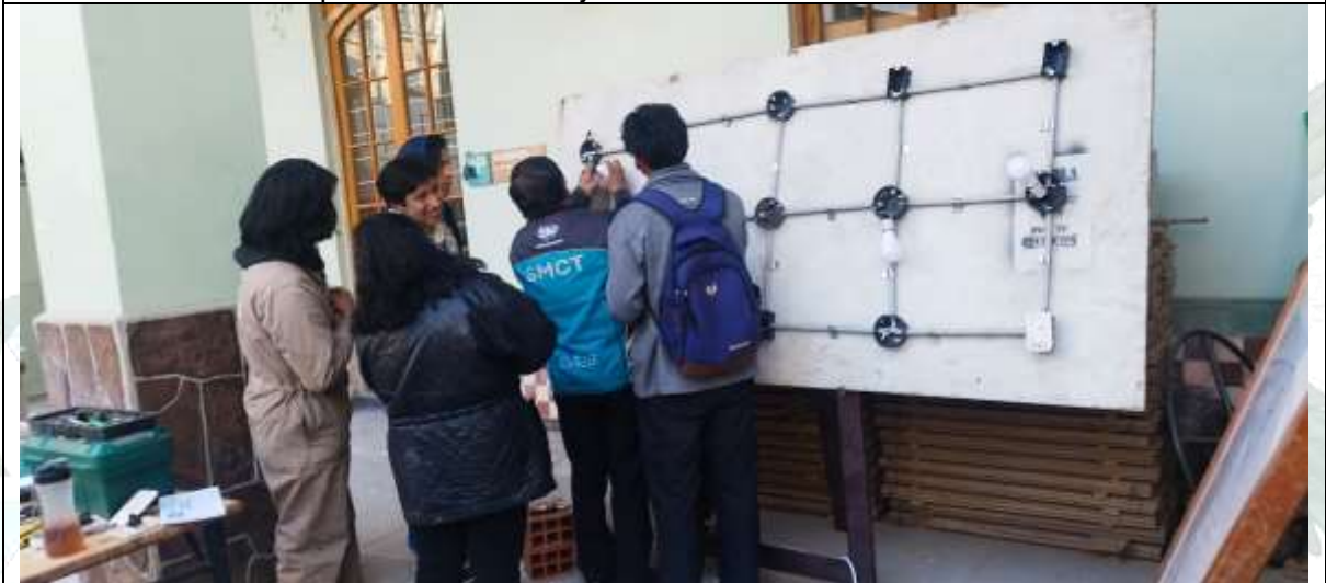
Clases teóricas presenciales, prácticas de instalación eléctrica
