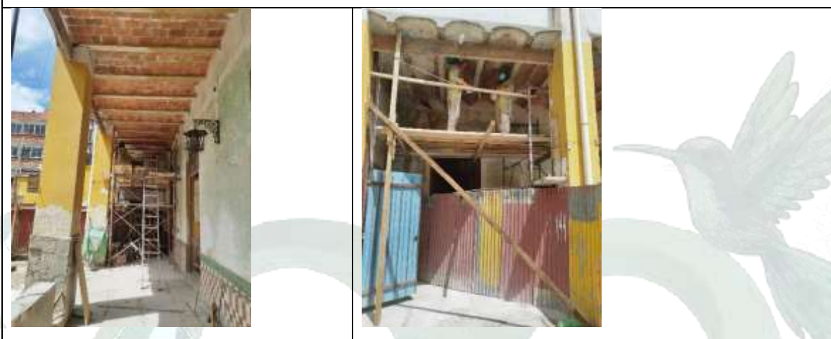
Liberación de añadidos en bovedillas en Juancito Pinto (en proceso)
