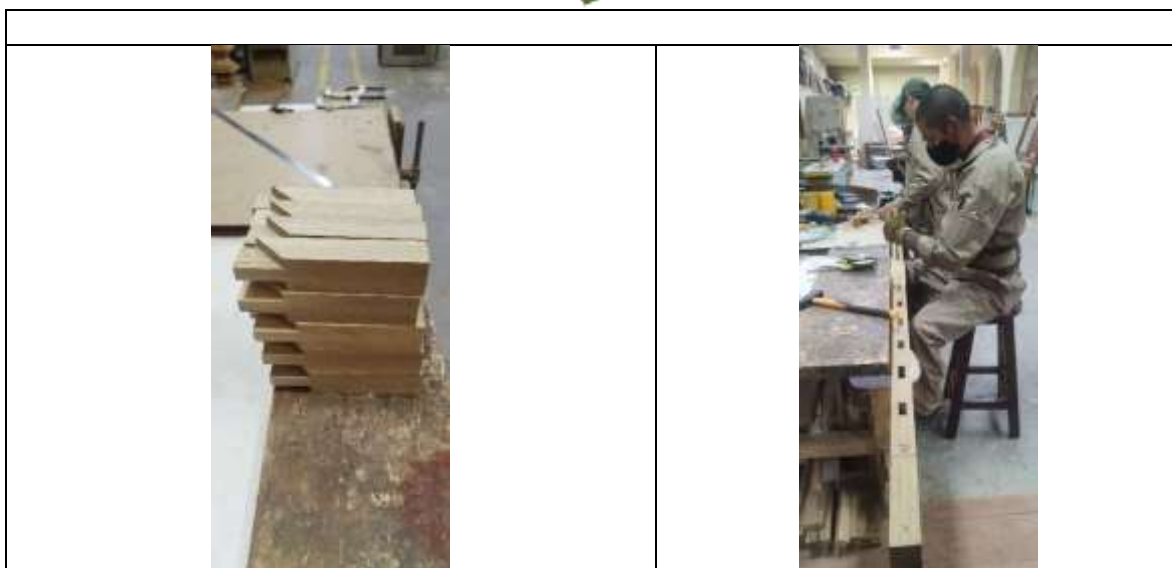
Construcción de una escalera para el altillo del taller Talla (en proceso)
