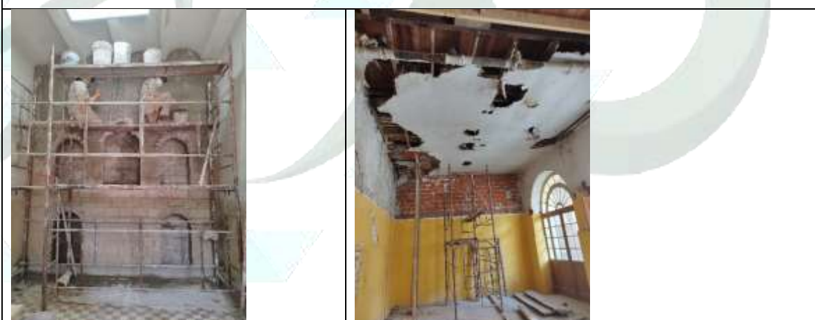
Revoque de cal y arena en Juancito Pinto (en proceso)
