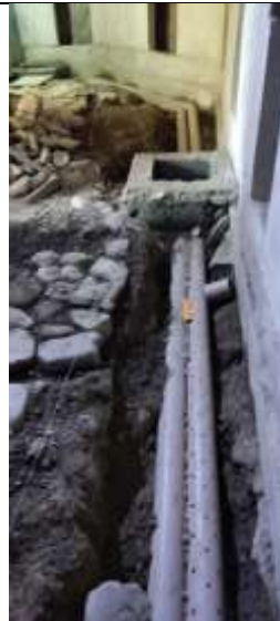
Excavación e instalación de tubería flexible perforada para drenaje PB
