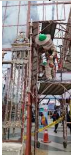
Restauración de la reja de seguridad del ingreso principal de la Terminal de Buses
