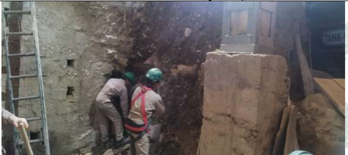
Excavación para el muro de contención
