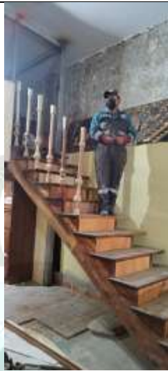
Proceso de instalación barrotes torneados del barandado de madera en gradas de la oficina del monitor de carpintería
