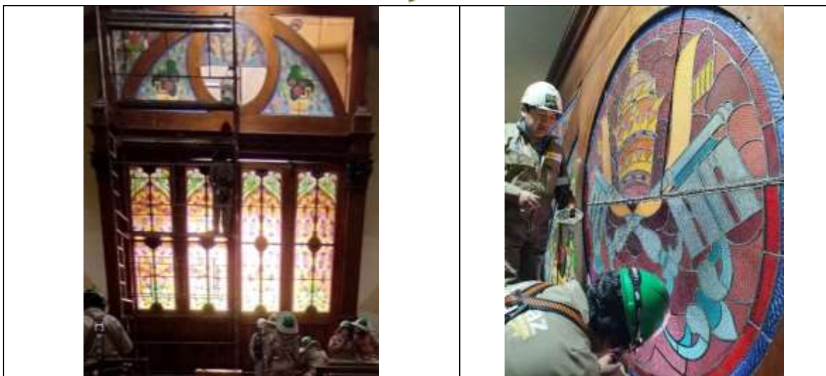
Restauración de vitrales de la mampara del ingreso principal a la nave central
