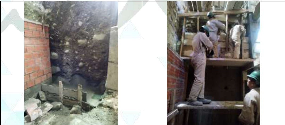
Construcción de muro de contención de hormigón ciclopeo
