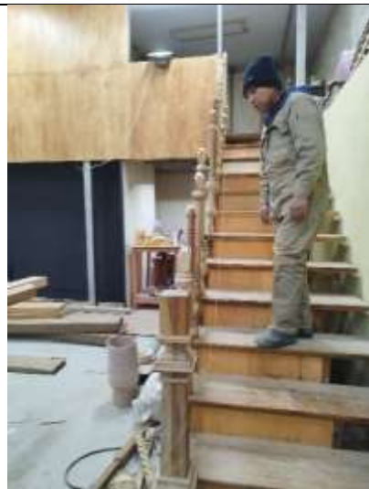
ensamblado de barrotes y pasamanos del barandado de las gradas de madera
