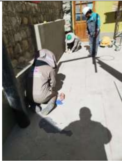
Trazado y emplazamiento de los mástiles
