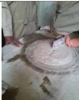
Elaboración de molduras corridas y moldes de goma en yeso
