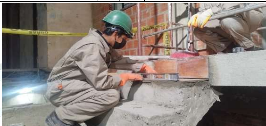
Colocado de piso ceramica en las gradas
