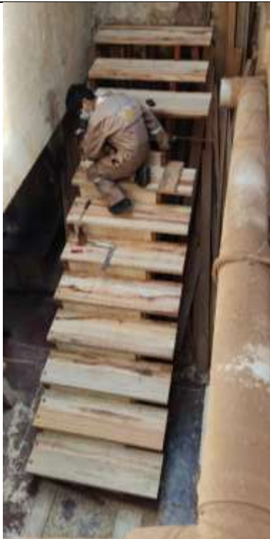
Armado de en seco de la escalera de madera
