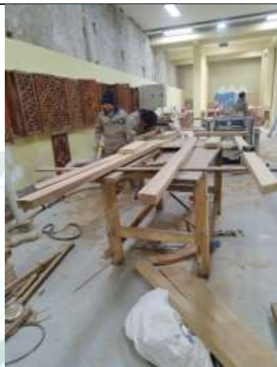
Construcción de puerta ambiente PB 06
