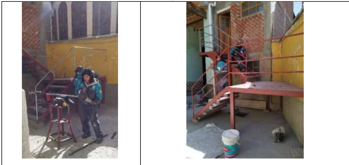
Construcción, instalación y pintado de la baranda metálico en gradas de los baños
