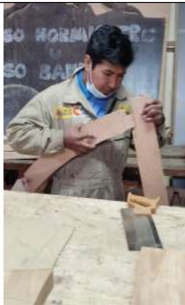
Ensamblado de las hojas de arco rebajado para el ambiente PB 05.
