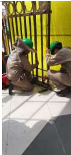
Consolidación y decapado de la capa pictórica del conjunto de la reja del ingreso principal de la Terminal de Buses La Paz
