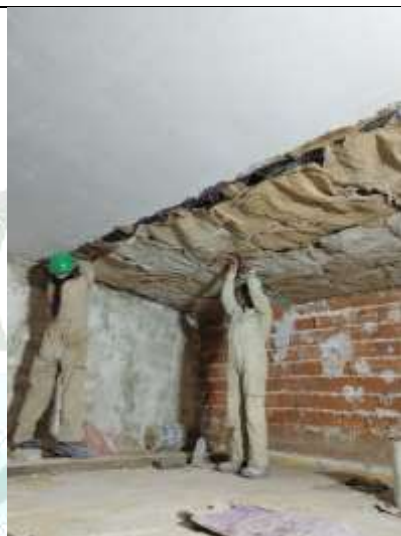
Revoque de yeso cielo raso ambiente PB 07
