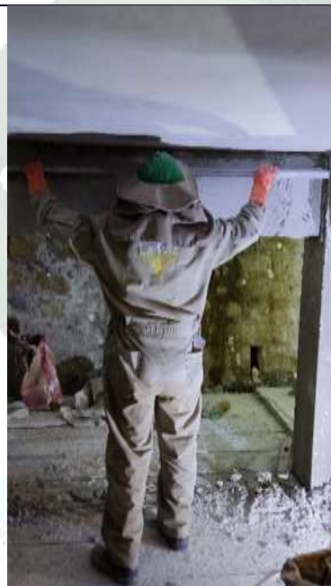
Revoque interior de yeso de vigas de H° A°
