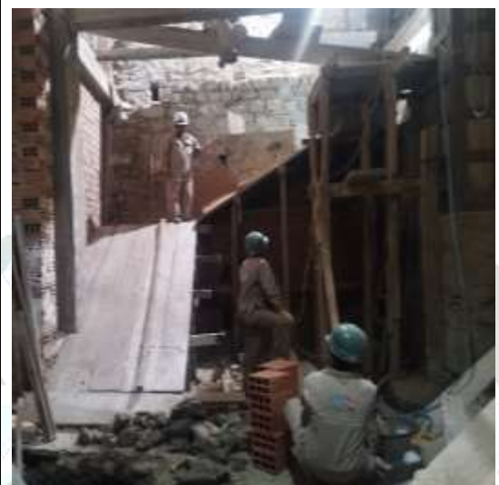
Encofrado para las gradas
