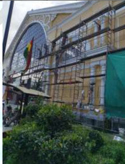
Masillado, pulido, pintura exterior látex y aplica capa protectora
