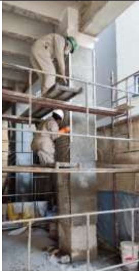
Revoque grueso de cal y arena con técnicas de acabado de falso mármol de la columna 4 PB 11
