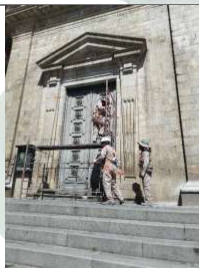
Armado de andamio para la restauración de vitrales y puertas laterales de la Catedral Metropolitana
