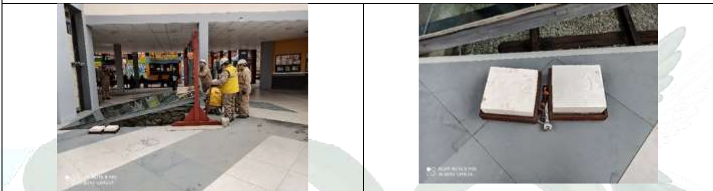
Tratamiento de control de humedad en la recuperación y puesta en valor de la vía férrea en la terminal terrestre
