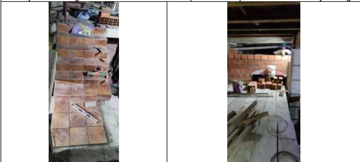
Colocado de piso cerámico en gradas
