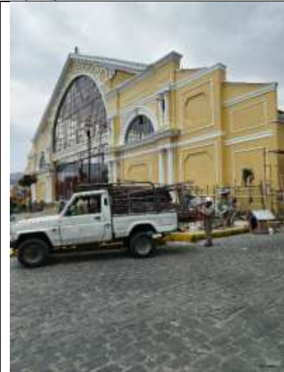
Masillado, pulido, pintura exterior látex y aplica capa protectora
