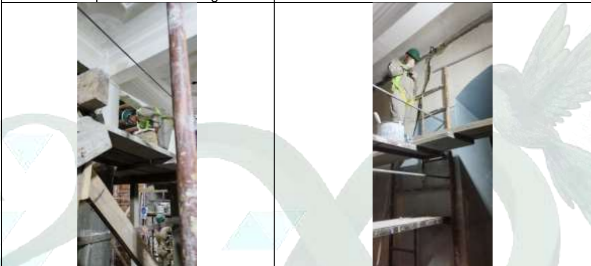
Elaboración de molduras corridas en sala teorcas
