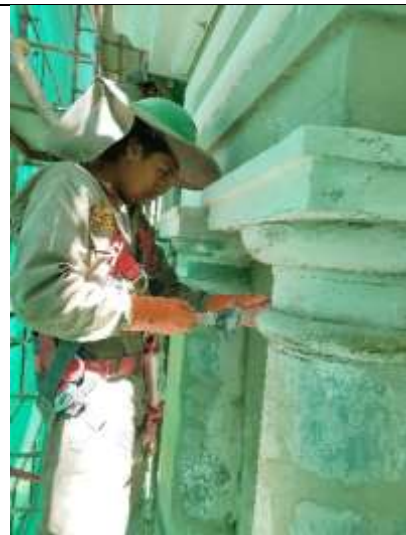
Reintegro de faltantes en elememntos ornamentales Fachada principal Terminal de buses
