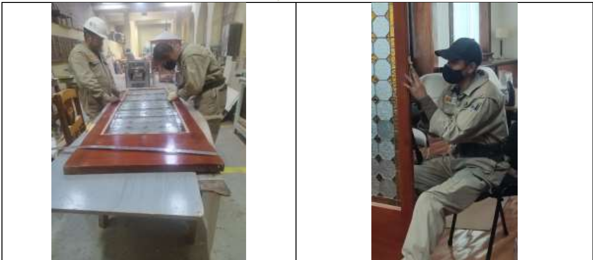
Instalacion de las puerta plegables de vitral en las oficinas de AECID
