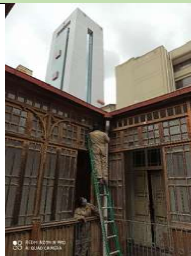
Limpeza de canaletas, reparación de la cubierta y bajantes en la sede de la ETRLP ubicado en la Calle Colón 379
