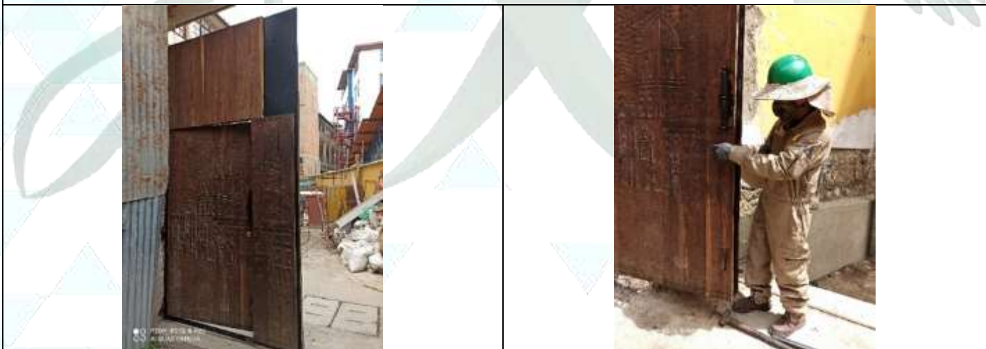
Instalación de accesorios y las hojas en la puerta de garaje en la nueva sede la ETRLP ubicado en la Calle Graneros (Juancito Pinto)
