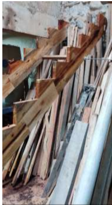
Soleras laterales de la escalera
