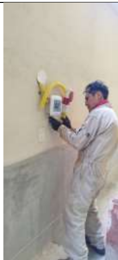
Instalación de tomacorrientes cabinas de probeta
