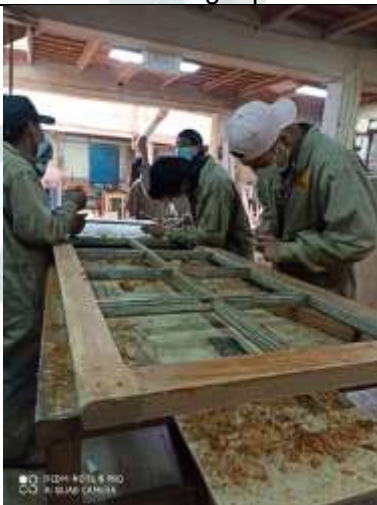
Restauración de puertas de madera de pino Oregón en proceso
