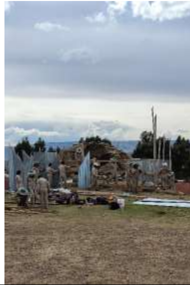
Trabajos de emergencia para la conservación preventiva de la Torre Funeraria de Chijipata
