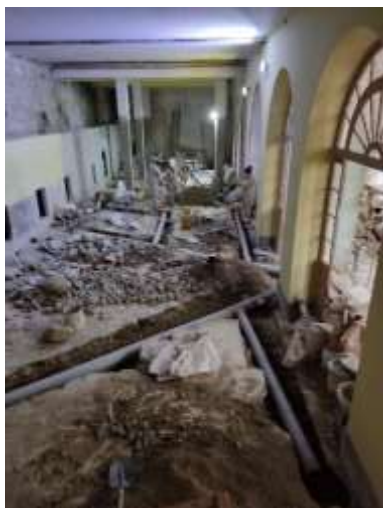
Excavación, provisión, instalación de tubería flexible para extractor de virutas y aserrín en el taller de carpintería.
