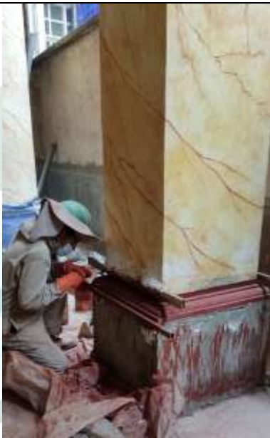
Revoque grueso de cal y arena con técnicas de acabado de falso mármol de la columna 4 PB 11
