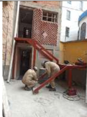
Construcción de escalera para el acceso al baño de damas en Juancito Pinto (en proceso)
