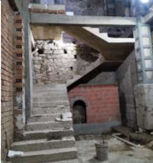
Desencofrado en gradas
