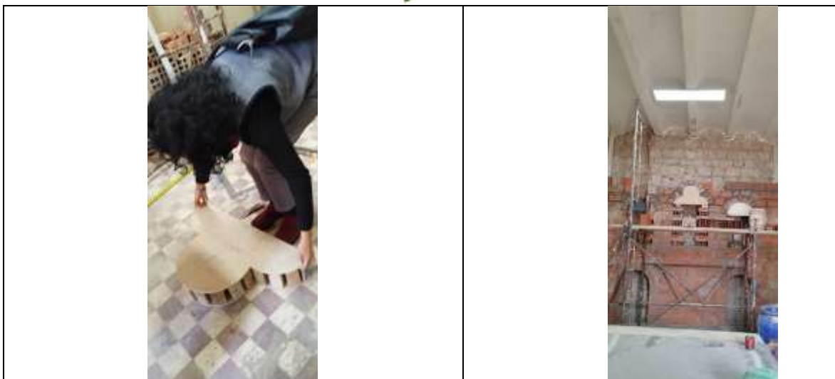
Cimbra para construir diferentes tipos de arcos
