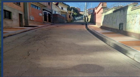
Reconstrucción de aceras y obras complementarias Ejecutado: Bs. 0.5 M
