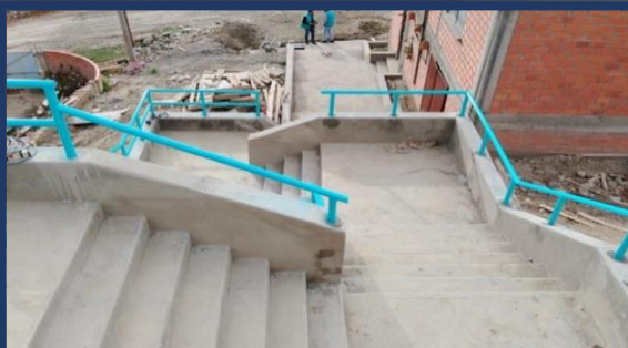
Construcción de graderías y obras complementarias ejecutada: Bs. 0.5 M
