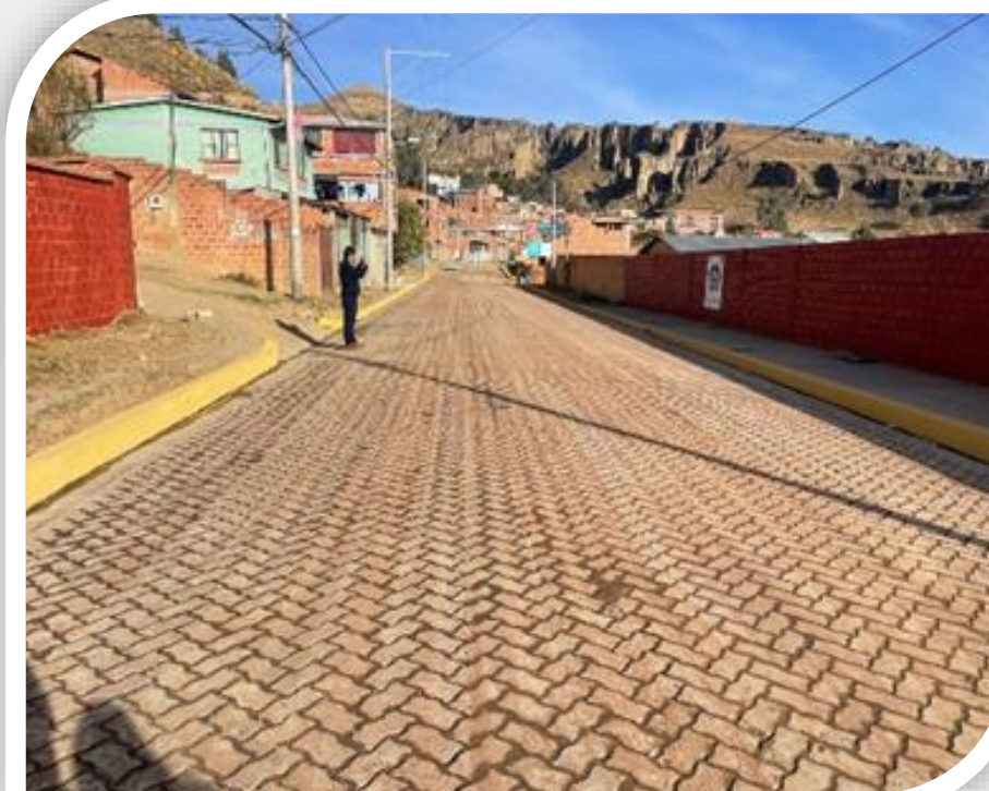
ENLOSETADO ZONA KELLUMANI CHIJPATA Monto Bs. 163.681,74
