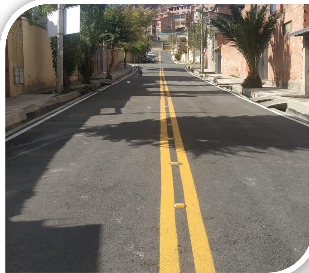
ASFALTADO Y OBRAS COMPLEMENTARIAS CALLE 7- ZONA MALLASILLA Monto Bs. 280.373,00
