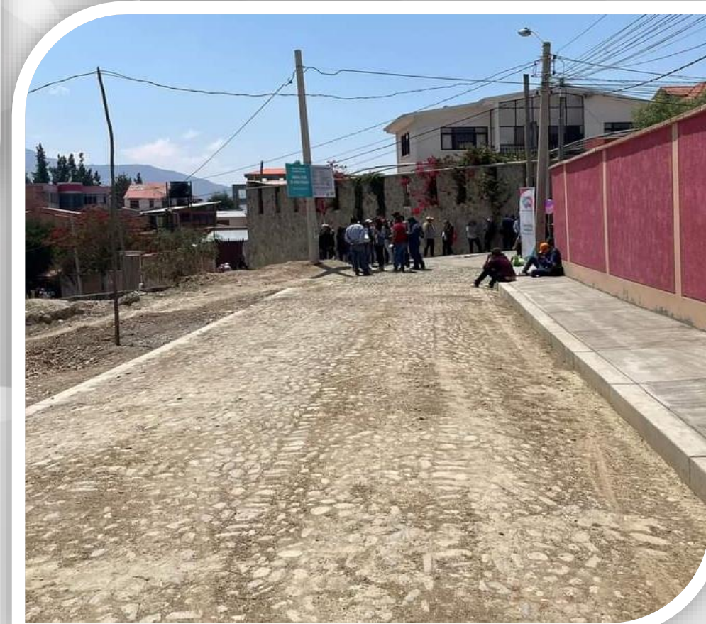
EMPEDRADO ZONA MALLASA Monto Bs. 220.429,00
