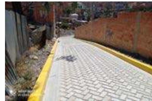
ENLOSETADO Y OBRAS COMPLEMENTARIAS SUR
