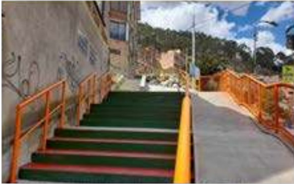
RECONSTRUCCIÓN GRADERÍAS Y OBRAS COMPLEMENTARIAS - PERIFÉRICA
