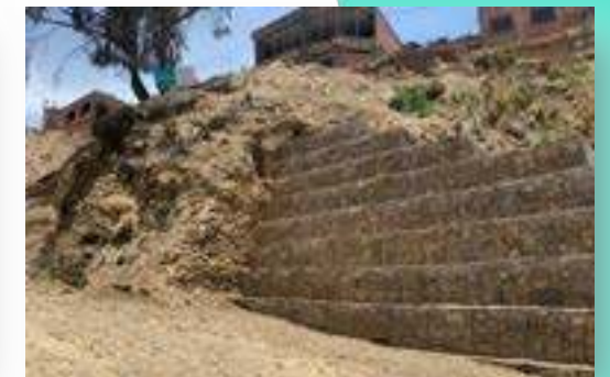
ESTABILIZACIÓN CON MURO DE GAVIONES MAX PAREDES
