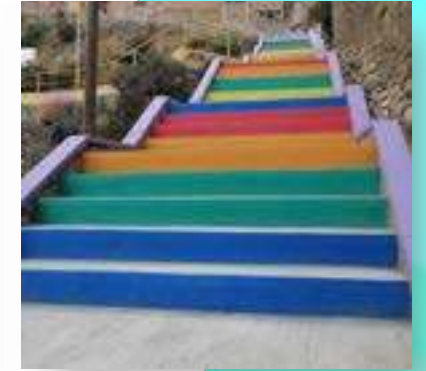
CONSTRUCCIÓN GRADERÍAS COTAHUMA
