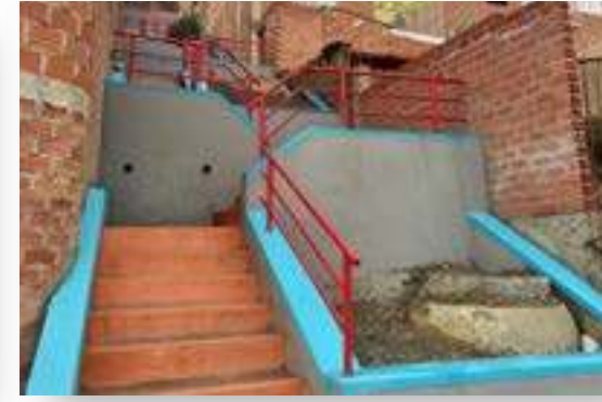
RECONSTRUCCIÓN GRADERÍAS COTAHUMA
