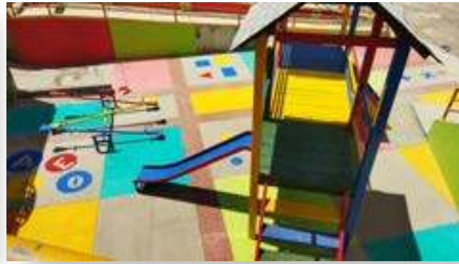
RECONSTRUCCIÓN ÁREA RECREATIVA MAX PAREDES
