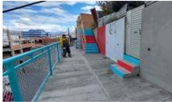
PINTURA GRADERÍAS JUAN MANUEL LOZA
