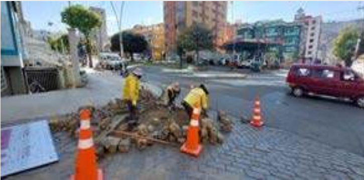
RECONFORMACIÓN DE ADOQUINADO
