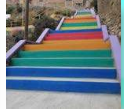
CONSTRUCCIÓN GRADERÍAS COTAHUMA
