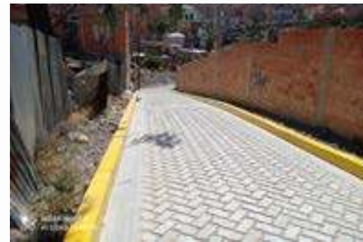
ENLOSETADO Y OBRAS COMPLEMENTARIAS SUR
