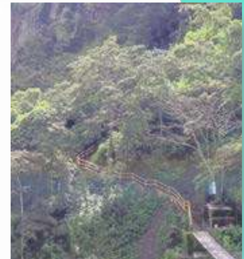
MEJ. DE ACCESO PEATONAL ENTRE PROGRESIVA 0+000 A 0+080 COMUNIDAD JARKA
