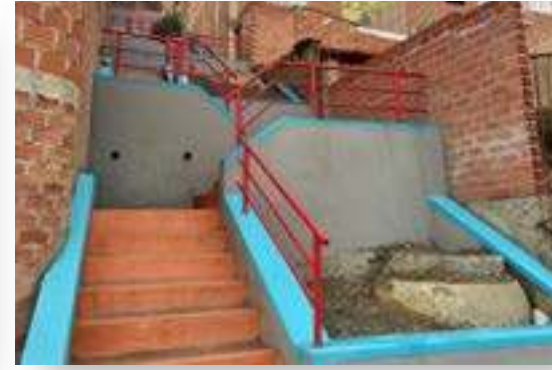
RECONSTRUCCIÓN GRADERÍAS COTAHUMA
