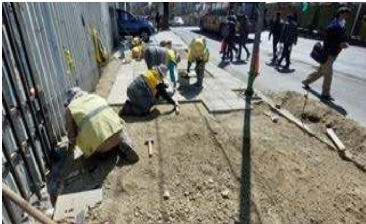
RECONSTRUCCIÓN PARCIAL DE ACERAS
