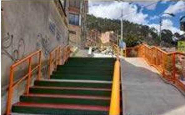
RECONSTRUCCIÓN GRADERÍAS Y OBRAS COMPLEMENTARIAS - PERIFÉRICA
