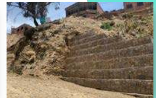
ESTABILIZACIÓN CON MURO DE GAVIONES MAX PAREDES
