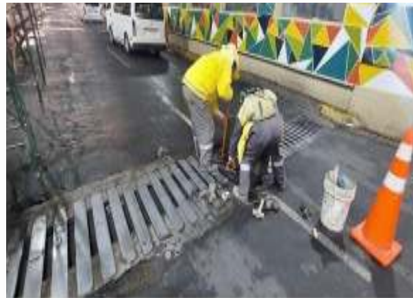
LIMPIEZA DE SUMIDEROS CALLE HONDA
