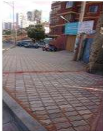
CONST. ENLOSETADO C. S/N 2 ENTRE C. PROLONG. MONTEVIDEO Y PJE. D. SAVIO ZONA UNIVERSIDAD - CANCHA ZAPATA
