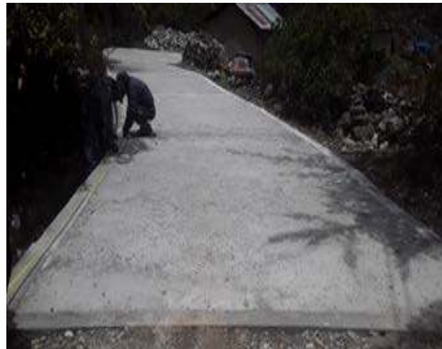
MEJ. VIAL TRAMO INGRESO A LA COMUNIDAD A CURVA U. EDUCATIVA DE PROG. 0+250 A PROG. 0+300 COMUNIDAD LLAULLINI
