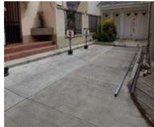
RECONST. ENCARPETADO Y OBRAS COMPLEMENTARIAS CALLE PROLONGACIÓN CORDERO Y PASAJE CORDERO ZONA SAN JORGE
