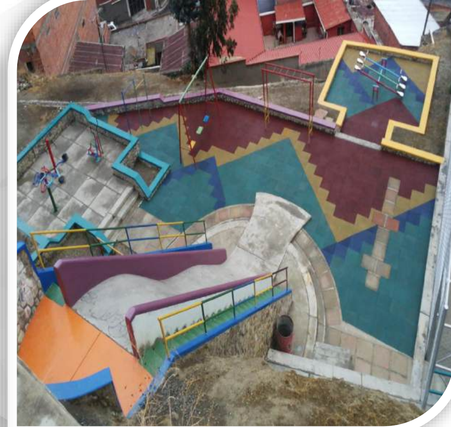
OBRAS DE MEJORAMIENTO ZONA HUANU HUANUNI Monto Bs. 219.126,65
