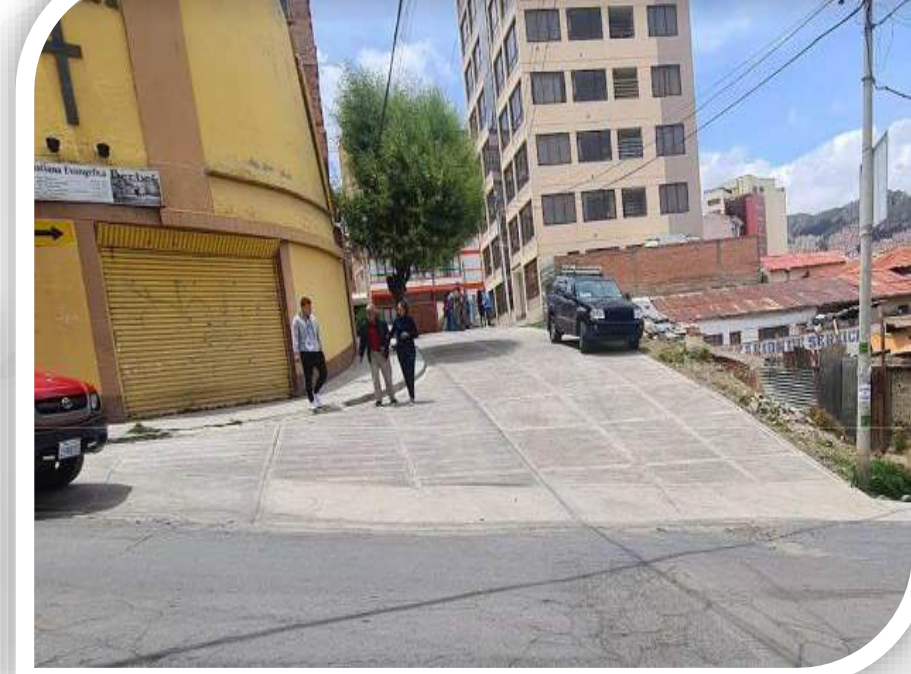
CONSTRUCCIÓN ENCARPETADO CALLE JOSE MARÍA CAMACHO Monto Bs. 114.209
