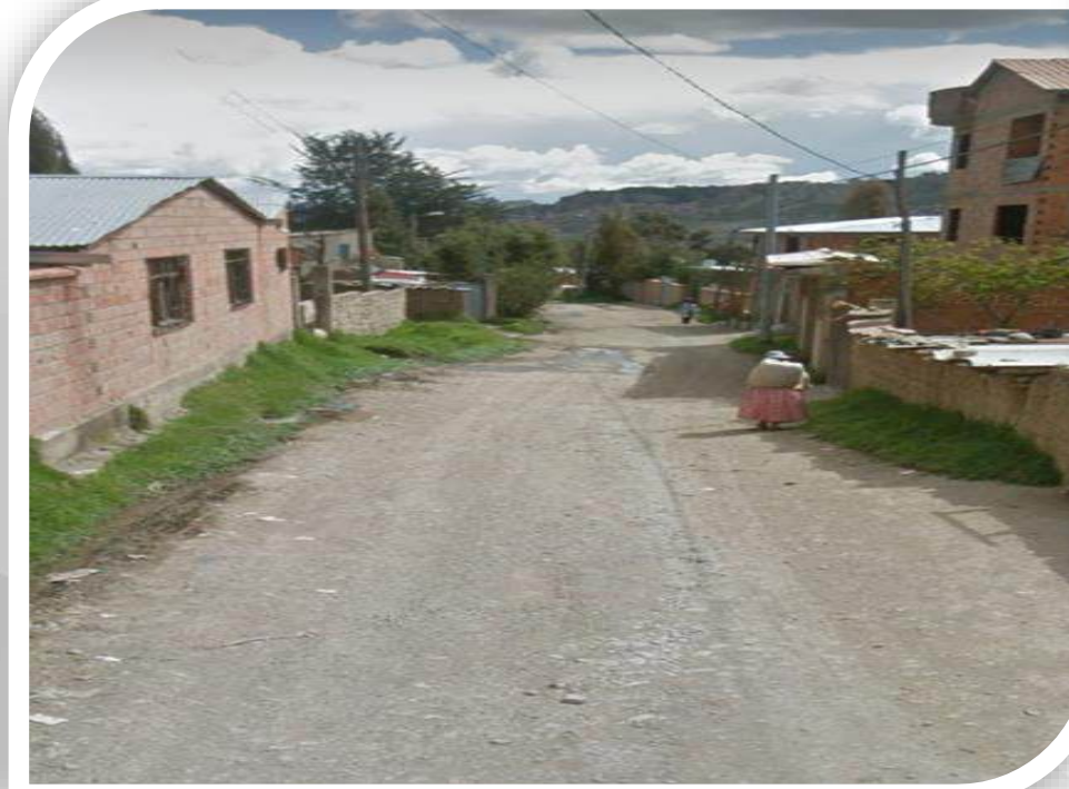
CORDONES DE ACERA Y OBRAS COMPLEMENTARIAS AV. PRINCIPAL CHICANI Monto: Bs.. 153.042
