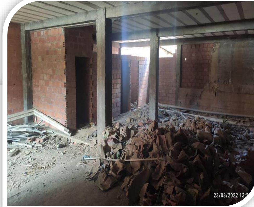
MEJORAMIENTO SEDE SOCIAL COMUNIDAD CHINCHAYA Monto: Bs. 98.717
