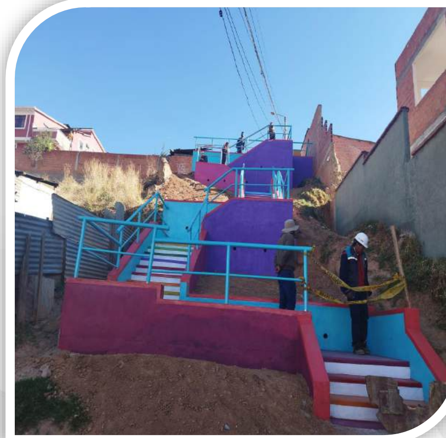
GRADERÍAS ZONA COMPLEMENTACIÓN PEDREGAL Monto Bs. 135.861,98
