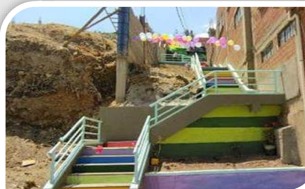
GRADERÍAS Y OBRAS COMPLEMENTARIAS ZONA 14 DE SEPTIEMBRE Monto Bs. 99.999
