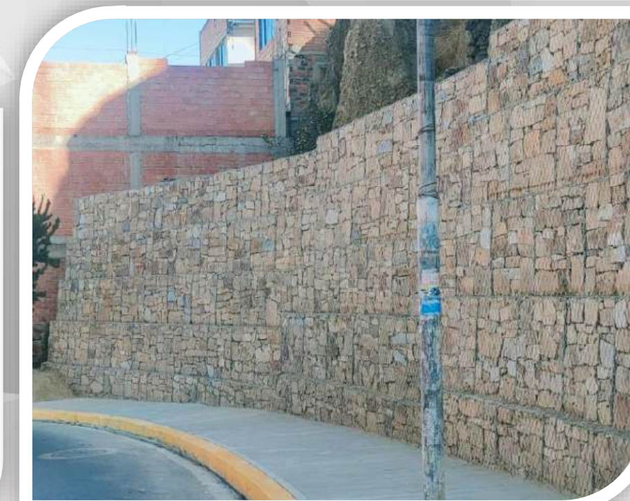
MURO DE GAVIONES AVENIDA 9 DE ABRIL Monto Bs. 169.996
