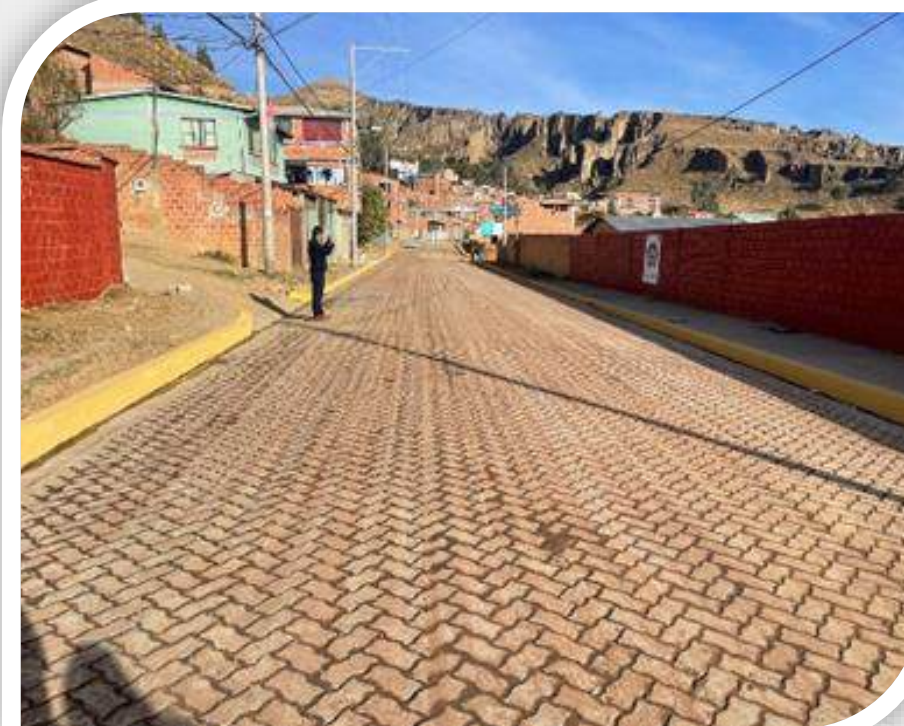
ENLOSETADO ZONA KELLUMANI CHIJPATA Monto Bs. 163.681,74
