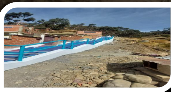
Construcción de graderías y obras complementarias Ejecutado: Bs. 3.1 M
