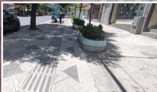
Construcción de aceras y obras complementarias programados: Bs. 0.9 M
