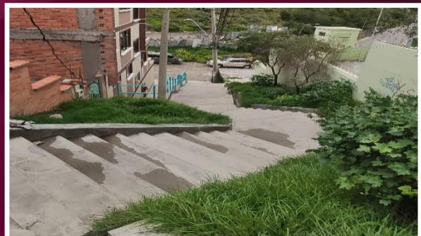
Construcción de graderías y obras complementarias programados: Bs. 1.6 M
