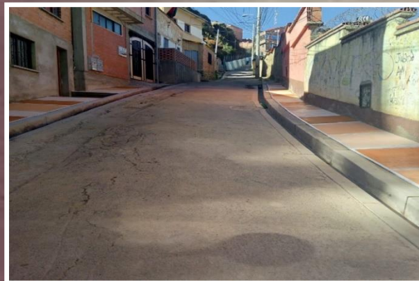
Construcción de aceras y obras complementarias programados: Bs. 0.2 M
