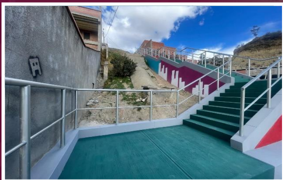
Construcción de graderías y obras complementarias programados: Bs. 0.7 M
