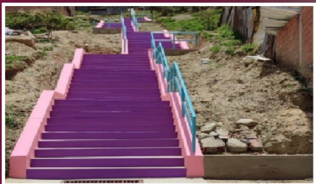
Construcción de graderías y obras complementarias programados: Bs. 1.7 M
