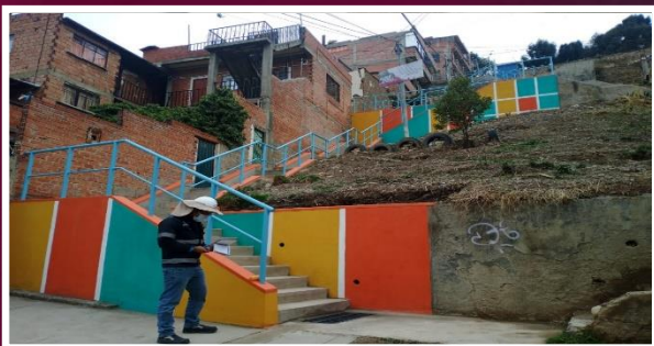
Construcción de graderías y obras complementarias programados: Bs. 4.6 M
