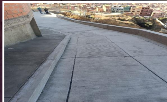
Construcción de aceras y obras complementarias programados: Bs. 1.6 M
