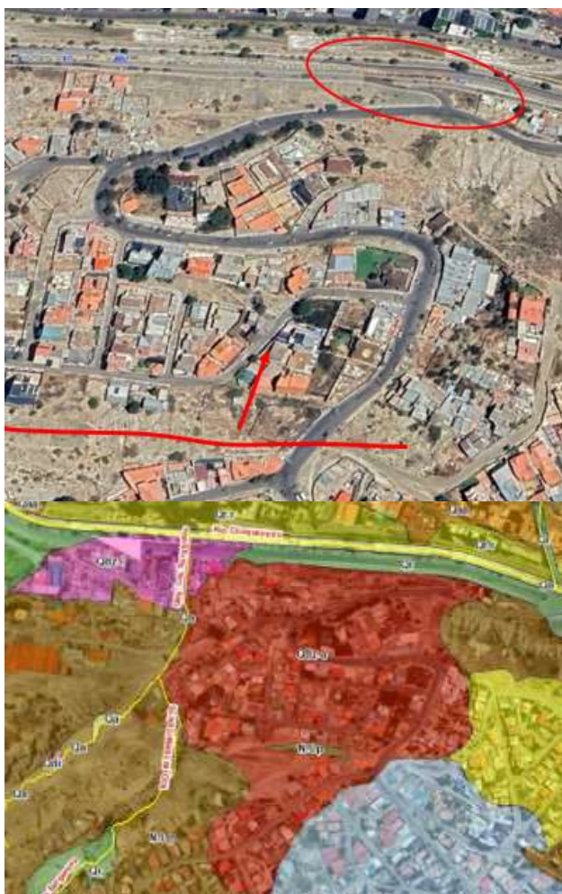
Fotografía 1. Ubicación de grieta de tracción y muro cajón.
