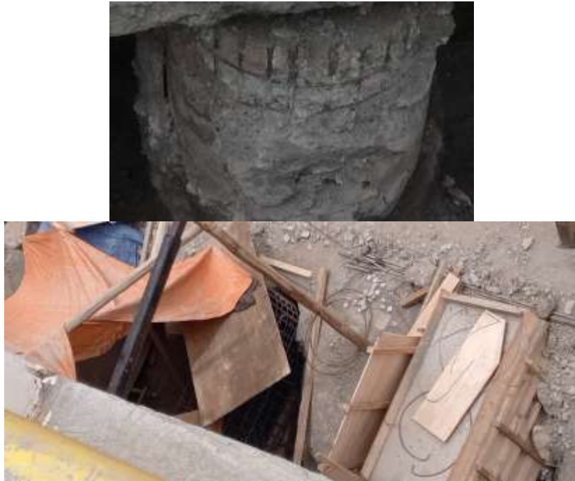
Fotografía 2. Sistema de viga de conexión y nuevo pilote
