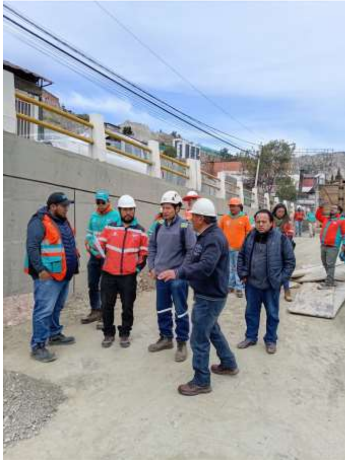
Ilustración 3 Sector Muro Cajón Costanera (calle 16 de obrajes)
