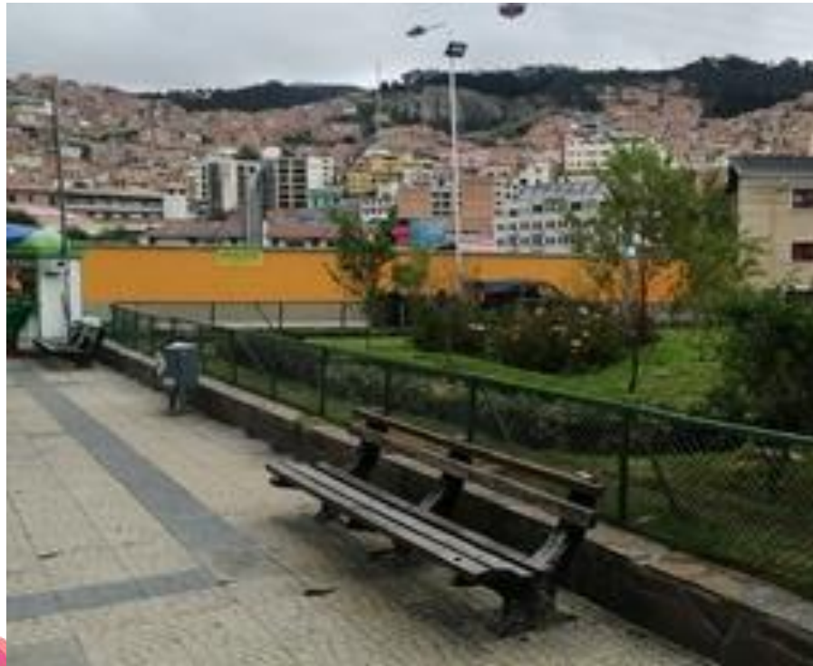
CONSTRUCCIÓN ÁREAS DE ESPARCIMIENTO PLAZA ALEXANDER - ZONA SAN SEBASTIÁN Monto Bs. 336.000 Plazo de ejecución 40 días calendario
