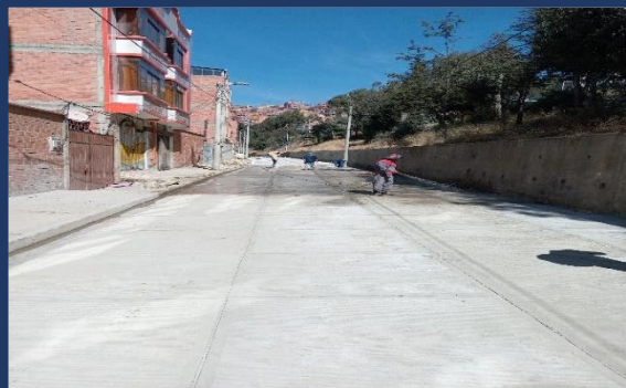
Obras de mejoramiento vial Ejecutado: Bs. 5.5 M
