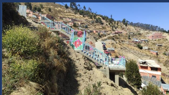
Construcción de graderías y obras complementarias Ejecutado: Bs. 1.3 M
