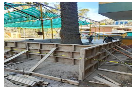
CONSTRUCCIÓN DE MACETERO PARA PALMERA U.E. LINDEMANN, OBRAJES
