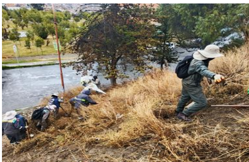
DESHIERBE Y LIMPIEZA TALUD AV. MAX PORTUGAL, ALTO OBRAJES
