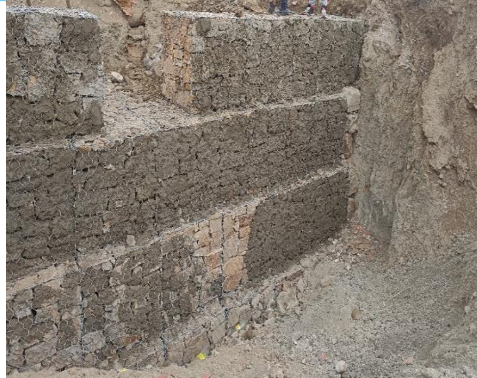
Construcción Muro De Gaviones Y Obras Complementarias Avenida 4 Entre Calle 20 Y Avenida 3 Zona Codavisa OBN-519-2023
