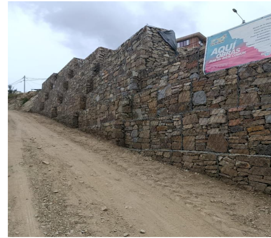
Ampliación Muro De contención Y Obras Complementarias Área De Equipamiento EQ-2 Zona Coqueni OBN-479-2025
