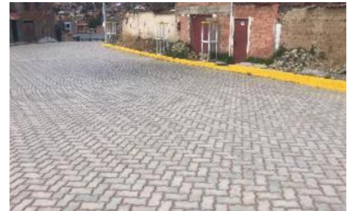
Enlosetado Calle Pio Xii Y Calle 20 Entre Calle Prolongacion 20 Y Av-5 Zona Bella Vista Central 1 OBN-159-2021
