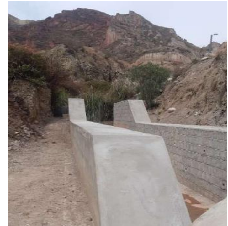
Construcción Canalización Y Obras Complementarias Rio Colorado Altura Calle P. S/N. 6, Zona Jose Reyes Carvajal OBN-65-2022
