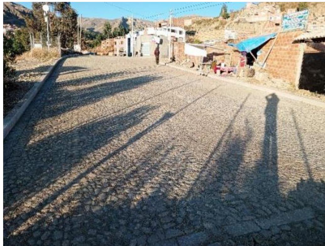
Construcción Empedrado Y Obras Complementarias Avenida A Entre Calle 1 Y Calle LI Zona Urbanización Los Rosales OBN-104-2024
