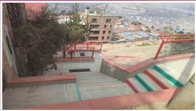
Construcción de graderías y obras complementarias programado: Bs. 1.3 M
