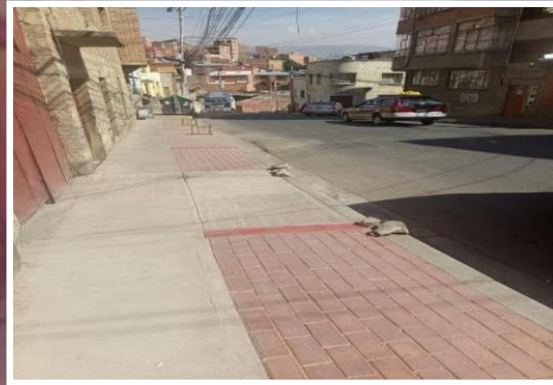
Construcción de aceras y obras complementarias programado : Bs. 2.7 M
