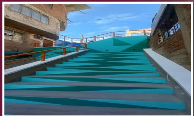
Construcción de graderías y obras complementarias programados: Bs. 3.2 M
