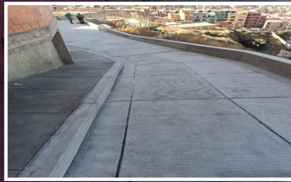
Construcción de aceras y obras complementarias programados: Bs. 1.6 M
